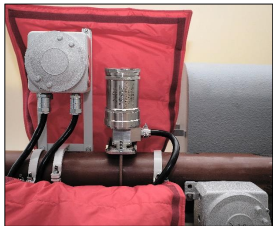
Компоновка ДСП-АКЭ-2 на газопроводе
